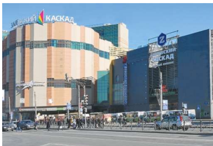
ТРК «Заневский Каскад», г. Санкт-Петербург
